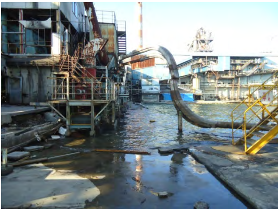
▲被災後の工場内
